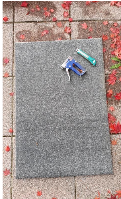
... mit Dachpappe verkleiden. verschrauben.
